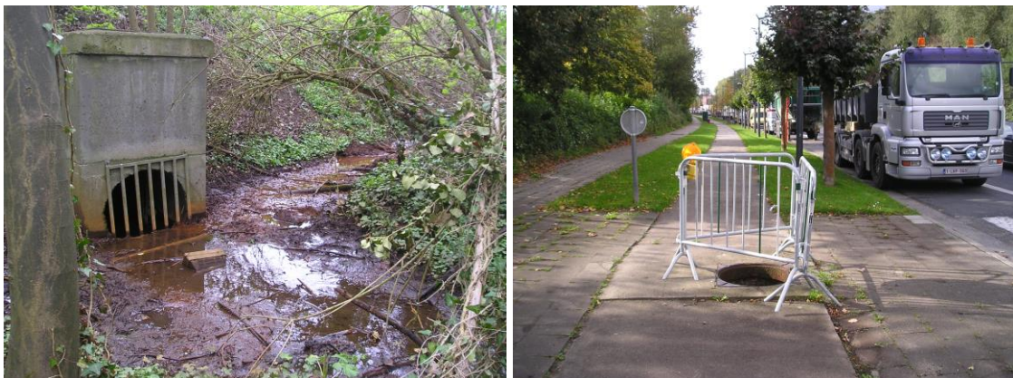
De uiterwaarden aan de Azuurstraat (links), waar de beek in een verzamelriool verdwijnt. Rechts een inspectiekamer aan de Hunderenveldlaan.
